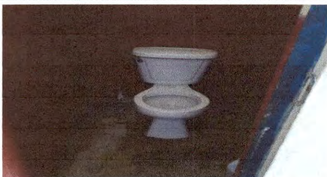
Foto 15: Sustitución de accesorios inodoro.
