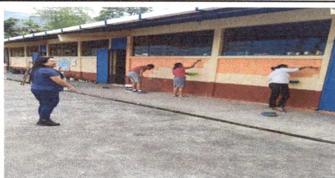
Foto 18. Pintura en muros interiores y exteriores.
