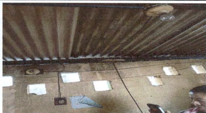
Foto 7: Reparación del sistema eléctrico.
