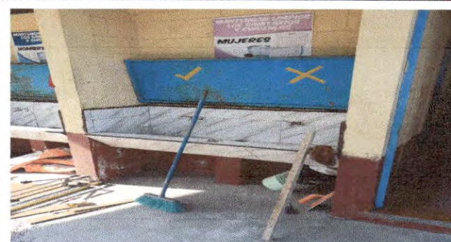
foto 16: Sustitución de azulejo.
