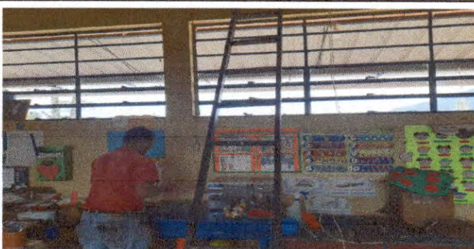
Foto 11: Reparación del sistema eléctrico más accesorios.
