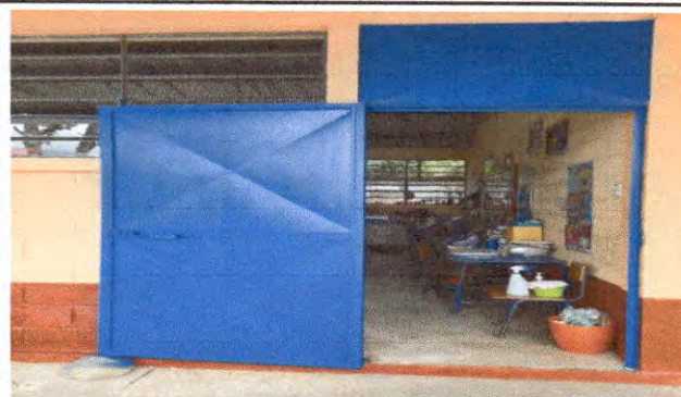
Foto 8: Puertas. Mantenimiento a estructura (lijado, cepillado, aplicación de pintura).
