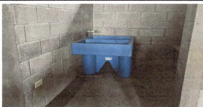
Foto 17. Sustitución de pila plástica de un lavadero. (incluye sistema de drenaje y conexión de agua)
