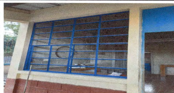
Foto 9: Mantenimiento a estructura de metal de ventana.
