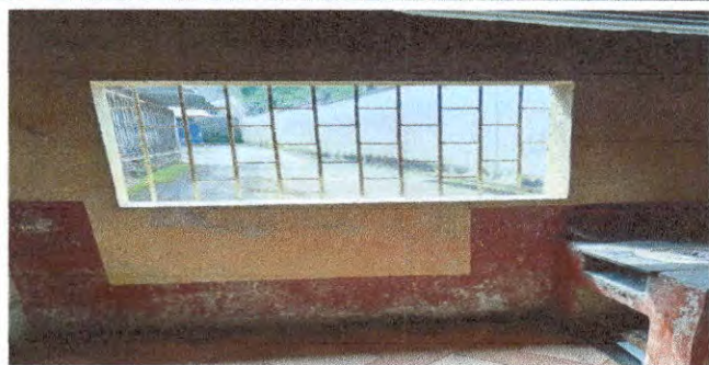
Foto 5: Sustrucción de ventana de metal por ventana de pvc.
